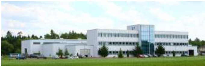
RAPID-Zentrale in Grosselfingen
